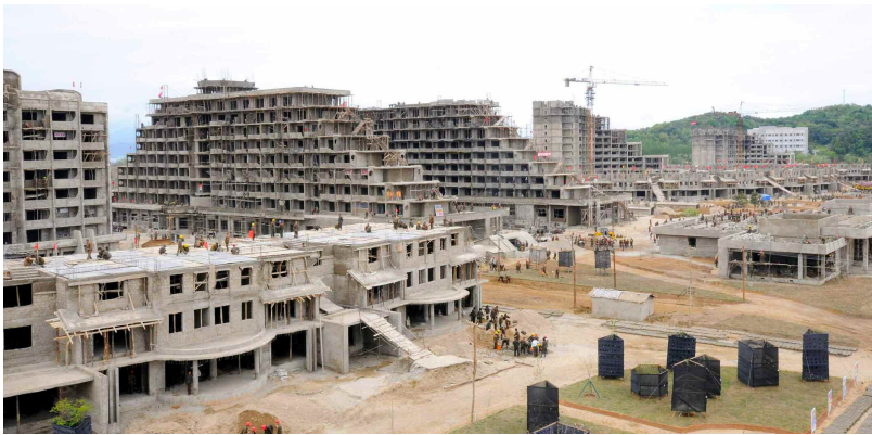
<사진 II-2> 원산갈마해안관광지구 건설현장
