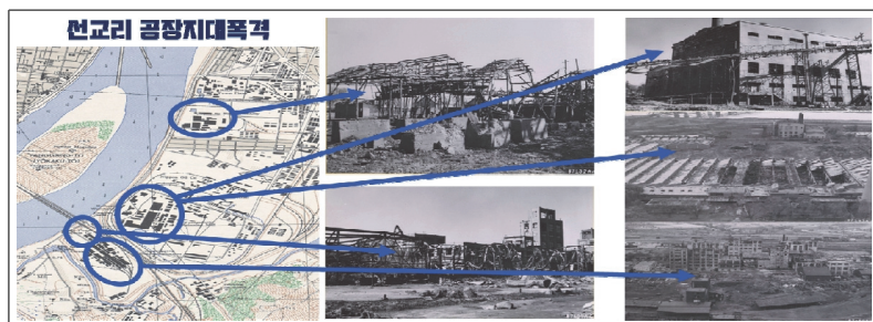
그림 IV-1 선교리 공장지대와 6.25전쟁 시기의 폭파된 공장 모습
