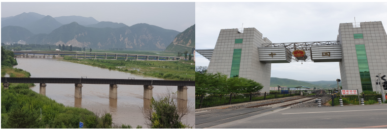
〈그림 Ⅲ-11〉 건설중인 투먼대교(도로) 〈그림 Ⅲ-12〉 투먼 철도 통상구
